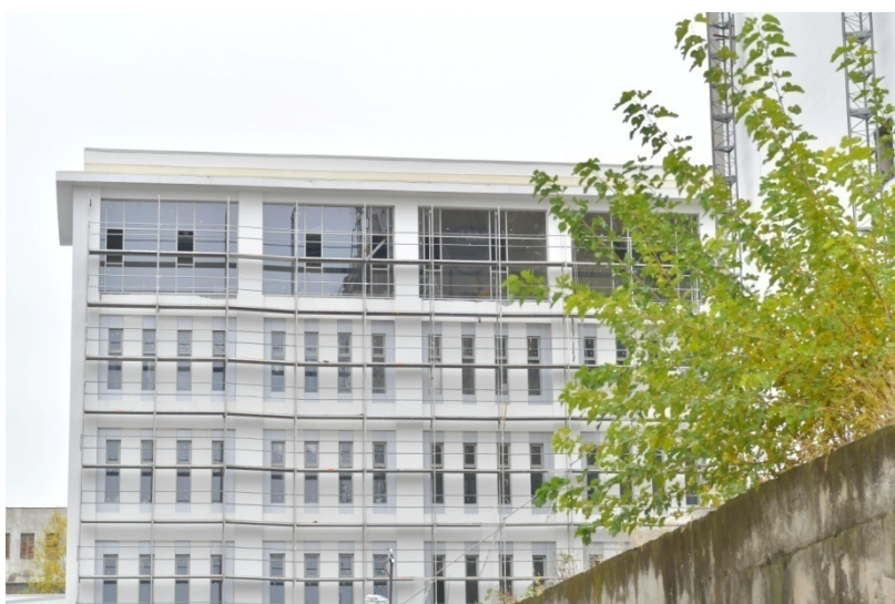
Campus Facultatea de Automatică, Calculatoare și Informatică și Facultatea de Inginerie Electrică
