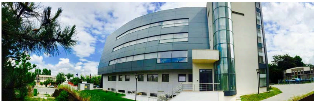
Sediul Infrastructurii de Cercetare în Științe Aplicate – INCESA
